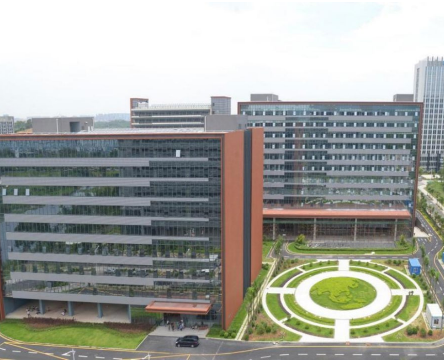
公司光伏发电项目
